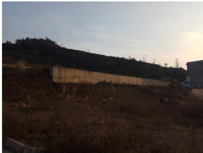
液化气灌装厂拆除现场
